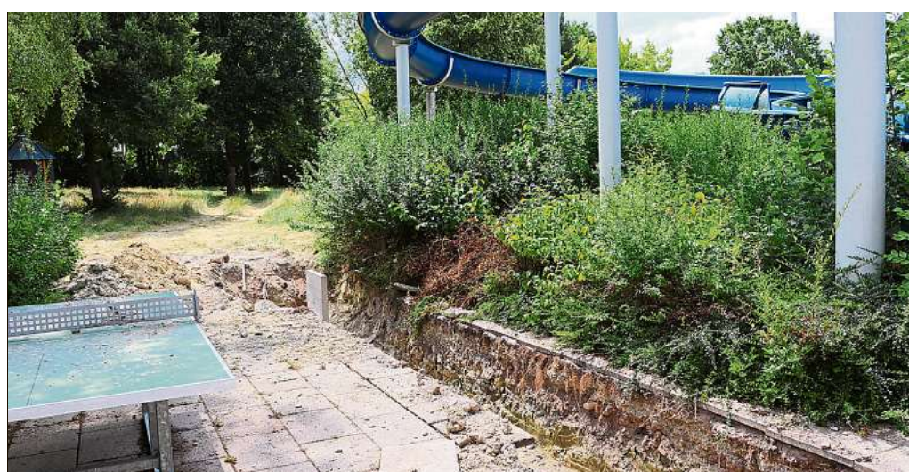
Unter der Rutsche soll ein neuer Duschplatz im Außenbereich gebaut werden. Die Rutsche und das dazugehörige Becken werden erhalten bleiben.
