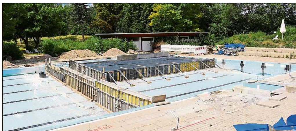
Auf der schwarzen Fläche wird im alten Außenbecken ein Wasserspielplatz entstehen.
