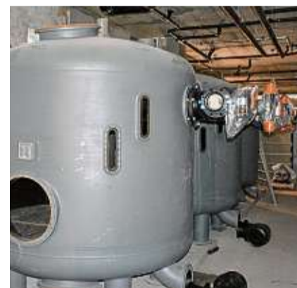
Einer dieser Filterkessel wiegt rund drei Tonnen. Es war ein enormer Kraftakt, die neuen Filterkessel an einem Stück an ihren Platz zu bekommen.
